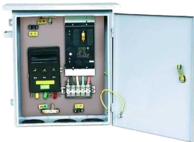
5.配电箱、开关箱应有名称、用途、分路标记及系统接线图，应配锁、并应由专人负责应定期检测、维修。检查、维修人员必须是专业电工。对配电箱、开关箱进行定期检查、维修时，必须将其前一级相应的电源隔离开关分闸断电，并悬挂“严禁合闸、有人工作”停电标志牌，严禁带电作业。
