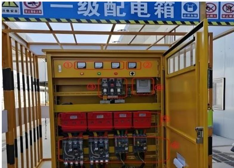
3.分配电箱应设置在用电设备或负荷相对集中的地方，根据需要设置若干分路，可不设漏电保护器。与总配电箱的间距大小应符合电压损失 $\gt;5\%$ 的技术条件，与开关箱的间距 $\gt;30\text{m}$ 。电器安装板上必须分设 N 线和 PE 线端子板。应装设总隔离开关、分路隔离开关，以及分路漏电保护器（不做强制要求），不得安装插座做电气连接。固定式配电箱的中心与地面的垂直距离应为 1.4~1.6m。移动式配电箱应设置在结实的支架上，其中心点与地面的垂直距离宜为 0.8~1.6m。
