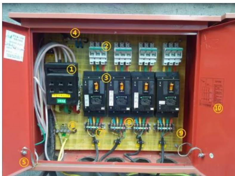
4.开关箱应设置在用电设备邻近的地方，必须按“一机一闸一漏一箱”设置，漏电保护器的额定动作电流应 $\leq 30\text{mA}$ ，额定动作时间应 $\leq 0.1\text{S}$ （特殊场合漏电保护器动作电流 $\leq 15\text{mA}$ ，动作时间应 $\leq 0.1\text{S}$ ）。与用电设备的水平间距 $\geq 3\text{m}$ 。
