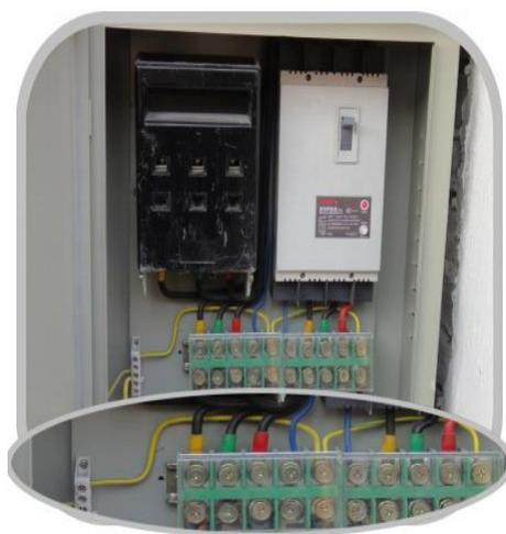
2.在 TN 接零保护系统中, PE 线应单独敷设, FE 线重复接地不少于三处, 在配电系统的首端、中间、末端处必须重复接地, 每处重复接地电阻值不应大于  $10.0\ \Omega$ 。
