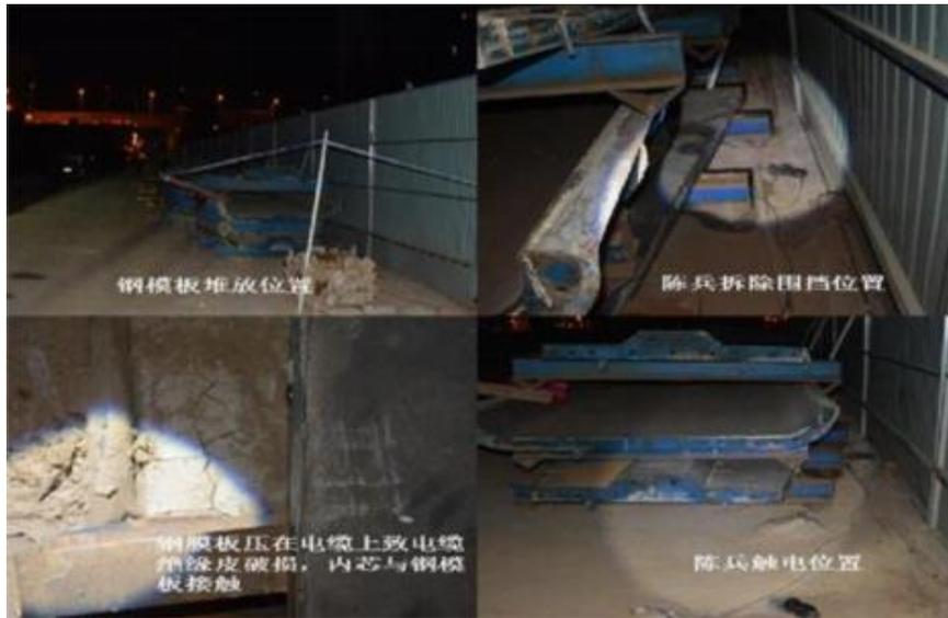
案例四：2021年3月26日，浙江杭州一工地违章搭建脚手架（疑似搭设外电防护架），导致人员触电，当场造成1死1伤。
